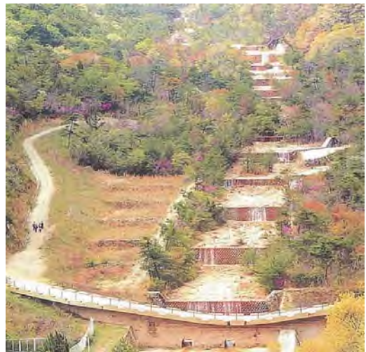
写真 2.1.10 太多田川砂防えん堤群
