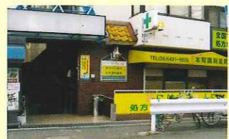
半地下利用の店舗 浸水は10cm程度だが店舗は水没。
