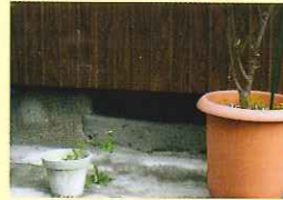
写真2:床下の通風孔 浸水する時は板などでふさぐ。
