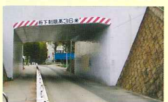
高架下のアンダーパス 周囲より低く浸水が深くなる。自動車が動かなくなり脱出できず死亡することもある。
