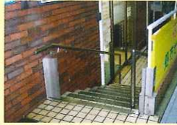
写真1:仕切り板を差し込む溝
