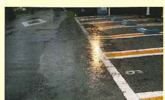
排水路の暗きよ化 1時間20mm程度であふれていた駐車場。水路を暗きよにするとつまってもわからない。
