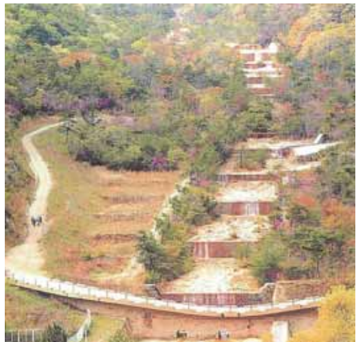
写真 2.1.10 太多田川砂防えん堤群
