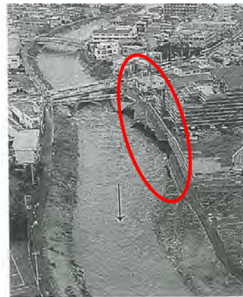
写真 4.15.1 大場川における被災状況(提供) 静岡新聞社
