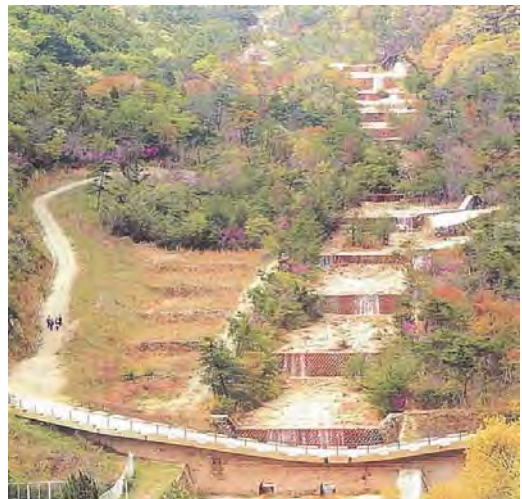
写真 2.1.10 太多田川砂防えん堤群
