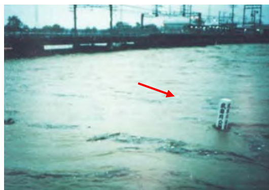
写真 2.1.7 昭和58年災害（阪神電鉄橋梁付近）
