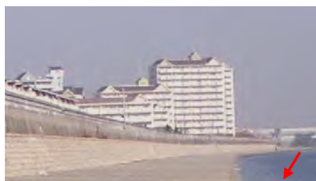
写真 2.2.5 高潮対策事業で整備した防潮堤
