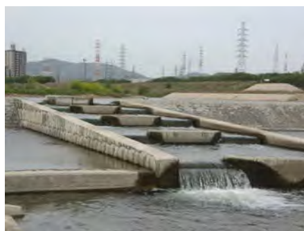
写真 2.2.24 床止めに設置された魚道
