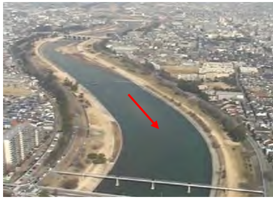
写真 2.2.1 下流部築堤区間
