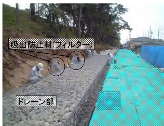
写真 2. 2. 4 堤防強化工事の例(ドレーン工)
