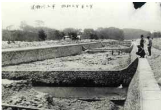
図 4.3.5 流路工施工後の昭和初期の逆瀬川
