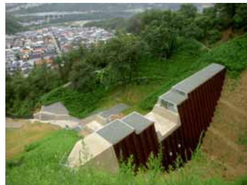
図 4.3.6 人家を守る土石流対策えん堤 高雄谷川（西宮市塩瀬町生瀬）
