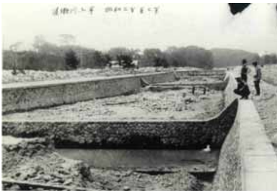
図 4.3.5 流路工施工後の昭和初期の逆瀬川
