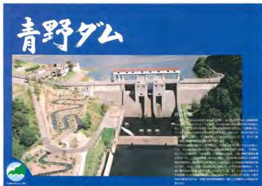
図 5.4.1 青野ダムと魚道
