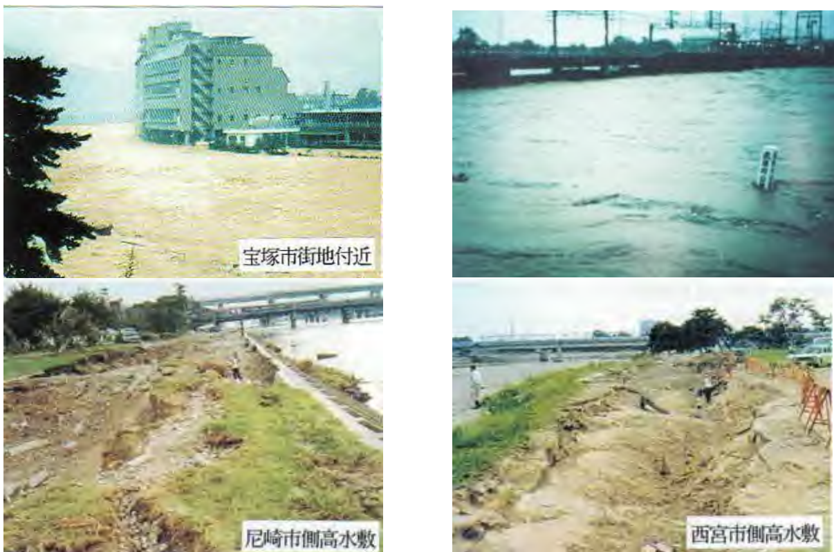
図 4.2.2 昭和 58 年 9 月 27 日洪水による被害
