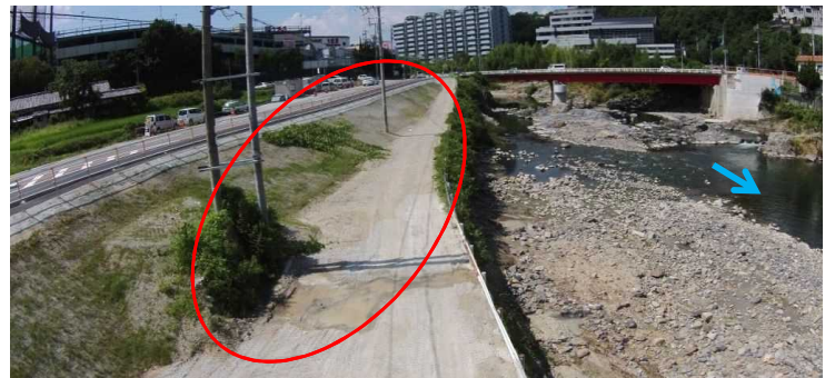
付替道路付近
