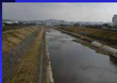
直線化した河道(三田市街地付近)
