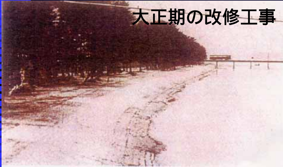
武庫川橋付近護岸 (武庫川改修第一期工事竣工)大正時代
