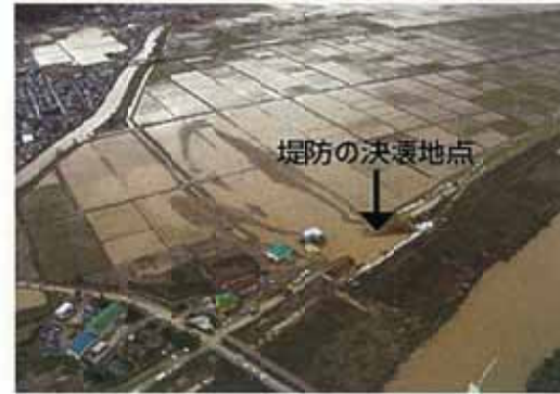
写真：国土交通省HPより
