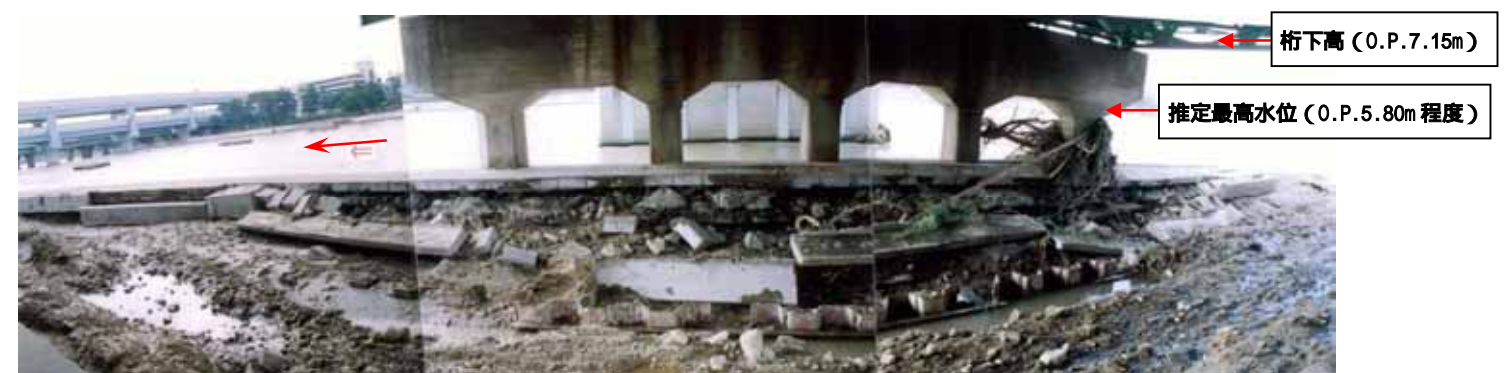
図 平成 16 年台風 23 号後の阪神電鉄橋梁の状況（草薙委員提供：第 26 回流域委員会 資料 3 より再掲）
