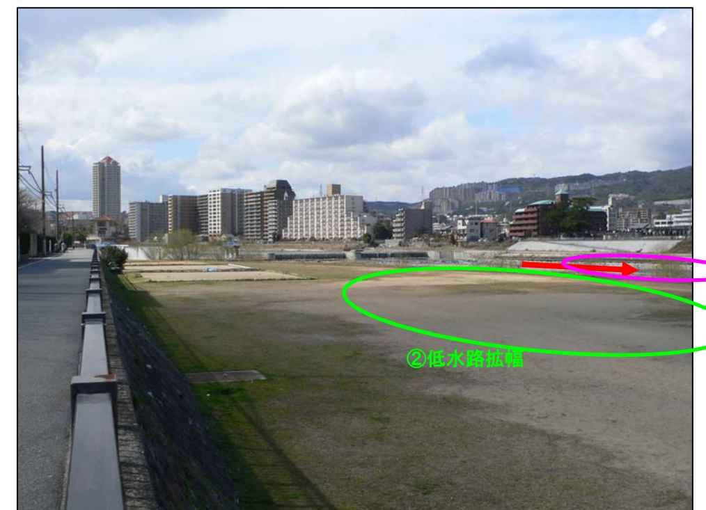
伊子志井堰下流 (13.0k 付近) 現況写真
