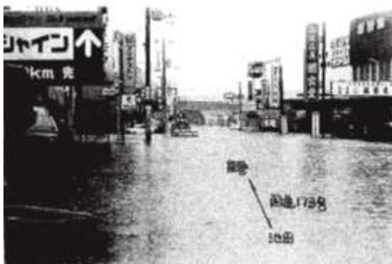
写真) 国道173号多田桜木付近の 浸水状況 (昭和58年9月)
