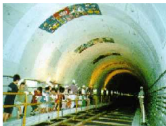
施設(貯留管)の内部
