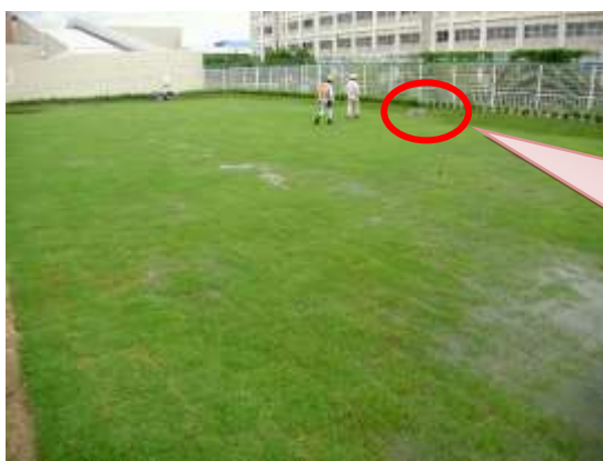
凹地(芝生エリア)に雨水が貯まりやすいよう、排水口を狭めている(オリフィス構造)。
