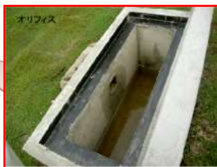
凹地(芝生エリア)に雨水が貯まりやすいよう、排水口を狭めている(オリフィス構造)。
