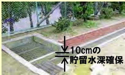
学校(校庭)における雨水貯留(川西南中学校)
