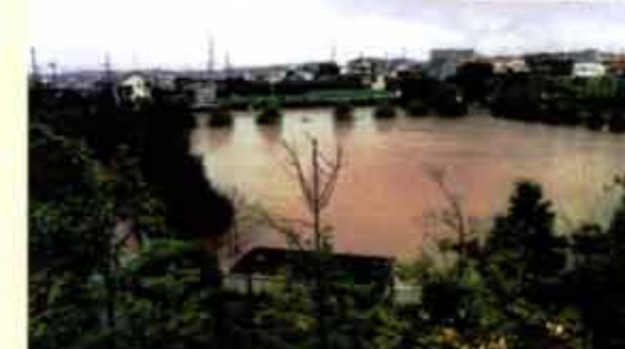
整備後の湛水時
