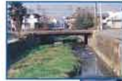
●下里川改修工事前
