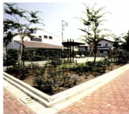
浸透池の上部は、公園に利用されています
