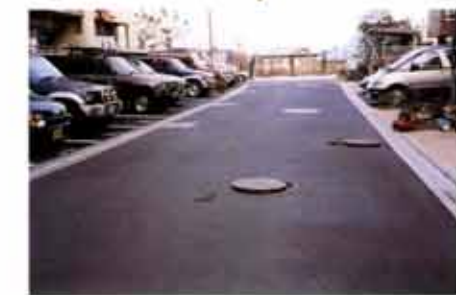
全景 (No.1地下貯留池)
