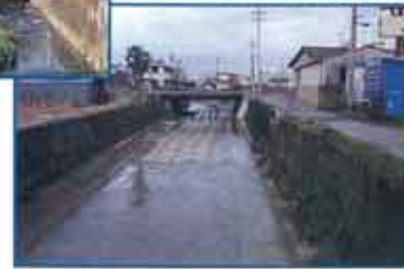
●下里川改修工事後
