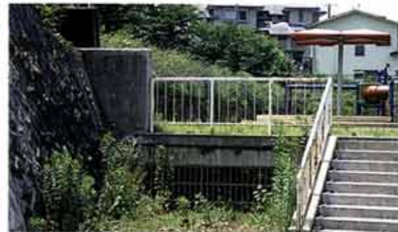
地下貯留槽がいっぱいになると中央の流出口から地上の公園部に貯留される
