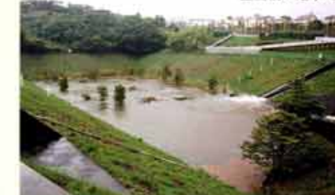
整備後の湛水時
