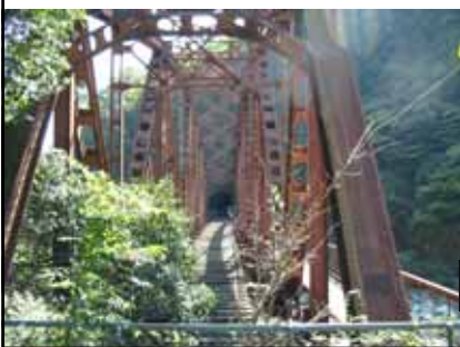
第2武庫川 橋梁
