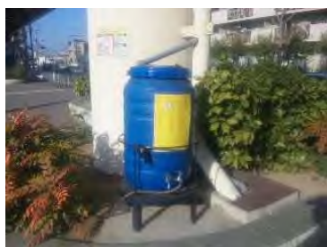
鉄道駅前の連絡通路下(川西市)
