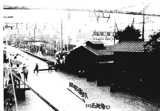
写真) 能勢電鉄鼓ヶ滝駅付近の 浸水状況 (昭和58年9月)
