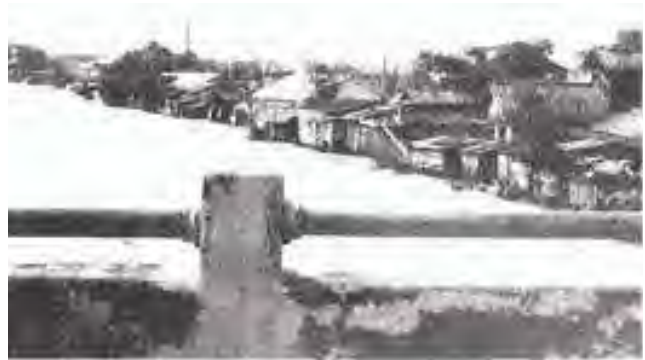
写真) 桑津橋(伊丹市)上流右岸橋上より 増水により民家が浸水し、流出の 危険にさらされている(昭和35年8月)
