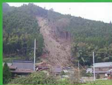
山崩れの被害
