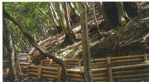
柵工(表土の流出を留める簡易防災施設)
