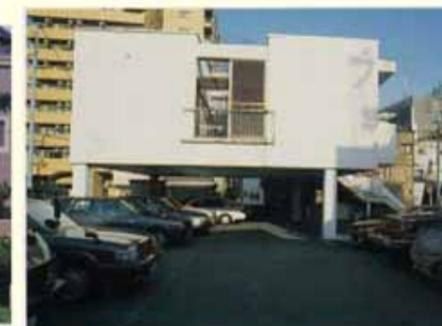
▲鶴見川多目的遊水地の中に建っているため、洪水時にも施設の利用が可能のようにピロティ構造とした
