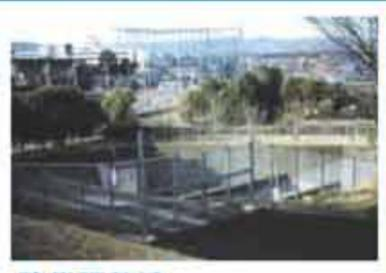
**防災調整池** 宅地造成等の市街地開発では河川への流出量が増大するため、防災調整池によって雨水を一時的に貯留し、流出を抑制します。
