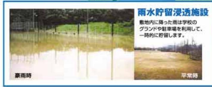
**雨水貯留浸透施設** 敷地内に降った雨は学校のグラウンドや駐車場を利用して、一時的に貯留します。
