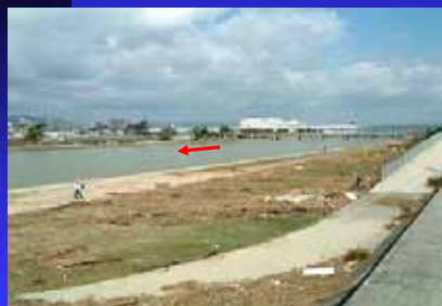
南武橋 下流左岸
