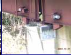
森興橋のジョイント部
