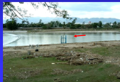
甲武橋 下流左岸
