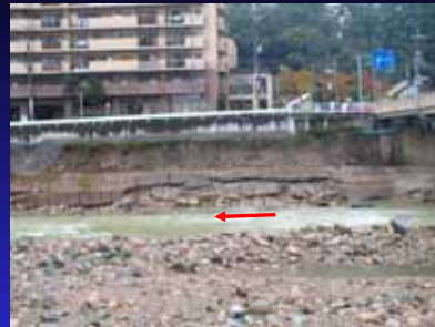
生瀬橋 下流右岸
