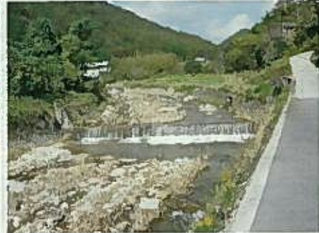
写真⑦：清水～杉生 —石積護岸や横断堰—
