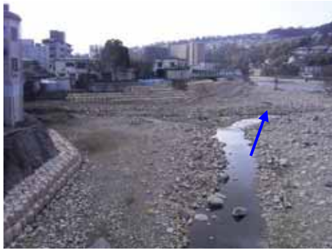
仮復旧（H17.2 時点）
