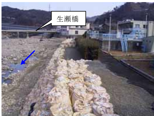
仮復旧（H17.2 時点）
