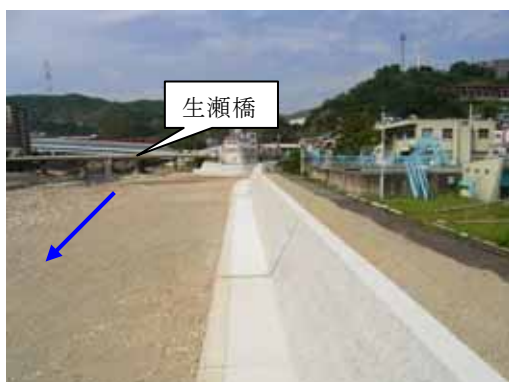
復旧完了（H17.10 時点）
