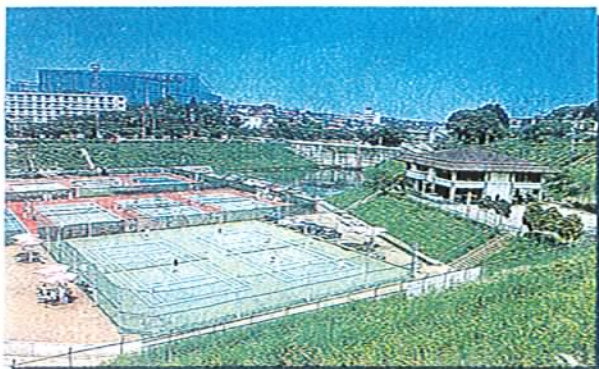
通常はテニスコートに利用している例 (霧が丘調節地・神奈川県)
