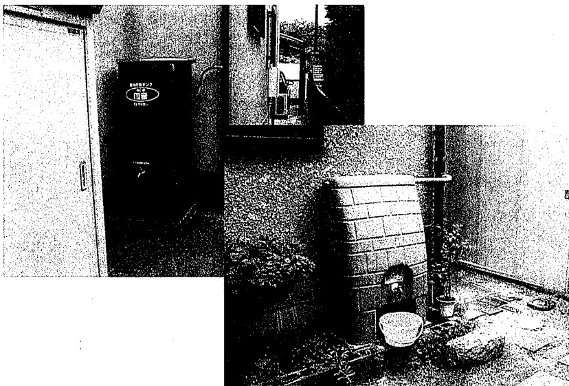
あまみず利用タンク設置状況
