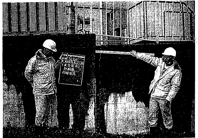
西宮市 浜ポンプ場 防潮堤破断
