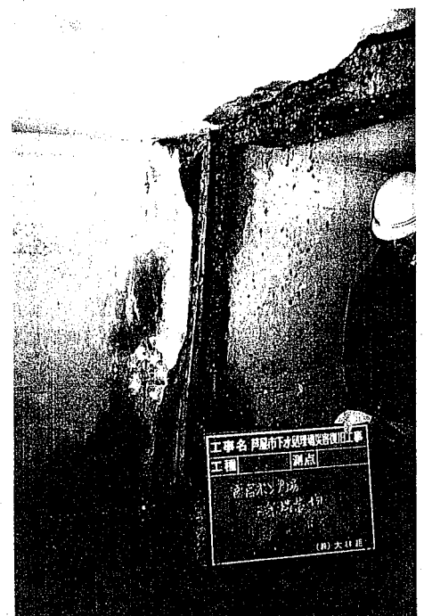
芦屋市 南宮ポンプ場 沈砂池流入渠破断
