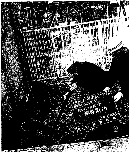
西宮市 上田南ポンプ場 雨水放流渠の破断による海水逆流
