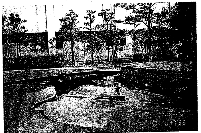
芦屋市 芦屋下水処理場 場内道路沈下
