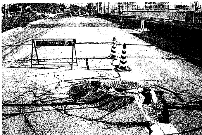
芦屋市 マンホールの浮き上がり
