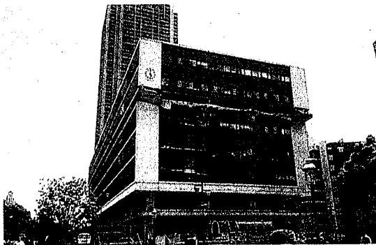
神戸市役所 2 号館 6F 破損状況 (下水道局 5F)
