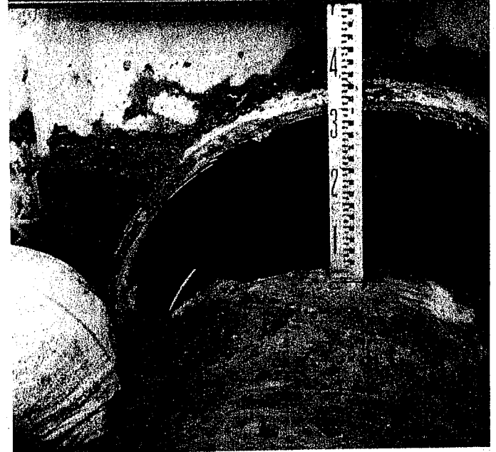
尼崎市 北部浄化センター 配管の破損
