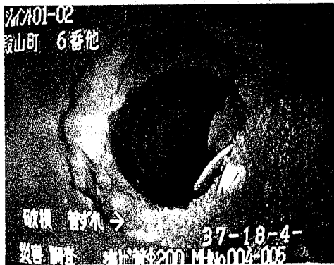
西宮市 塩ビ管の破損
