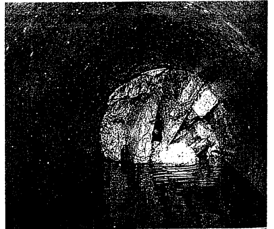
芦屋市 ヒューム管の崩壊
