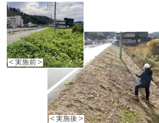
河川堤防の点検前除草
