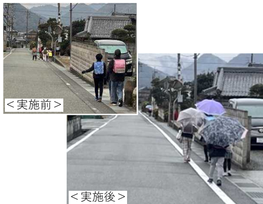
道路区画線の引き直し
