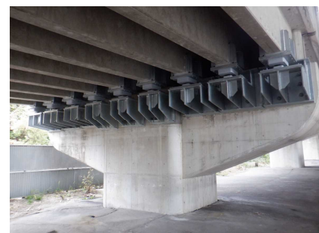
夙川橋 橋梁耐震 (芦屋市)
