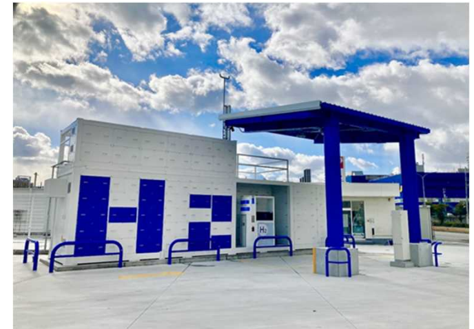
エア・リキードMK神戸空港前 水素ステーション
