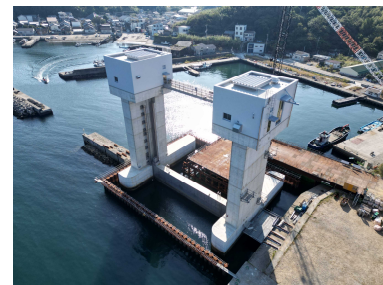
沼島漁港 水門整備
