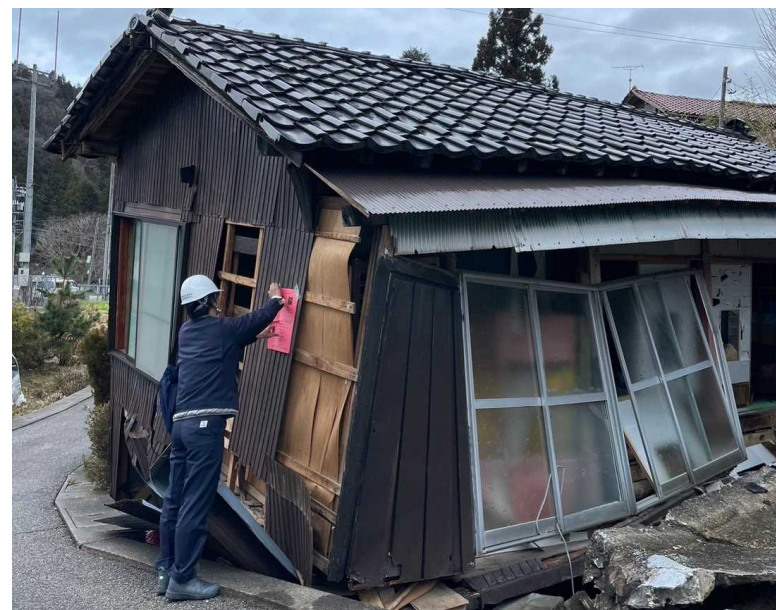
【被災建築物の応急危険度判定の様子 1/20】
