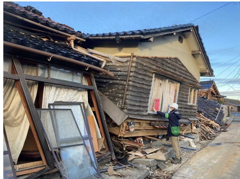
【被災建築物の応急危険度判定の様子 1/17】
