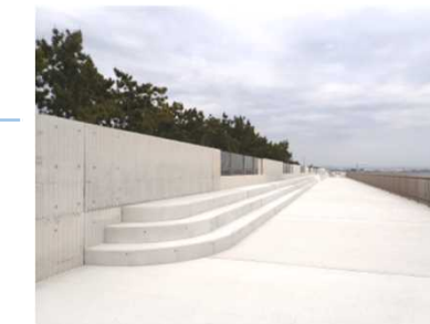
尼崎西宮芦屋港海岸 高潮対策(防潮堤嵩上げ)
