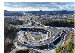
東播磨道小野ランプ付近 (R7.11 全線開通)
