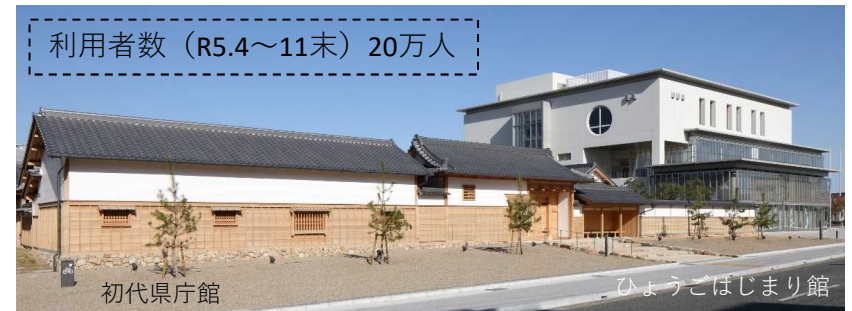
【兵庫津ミュージアム外観】
