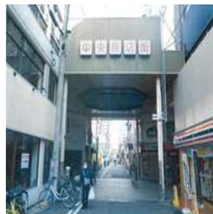
尼崎中央四丁目商店街振興組合 アーケード改修
