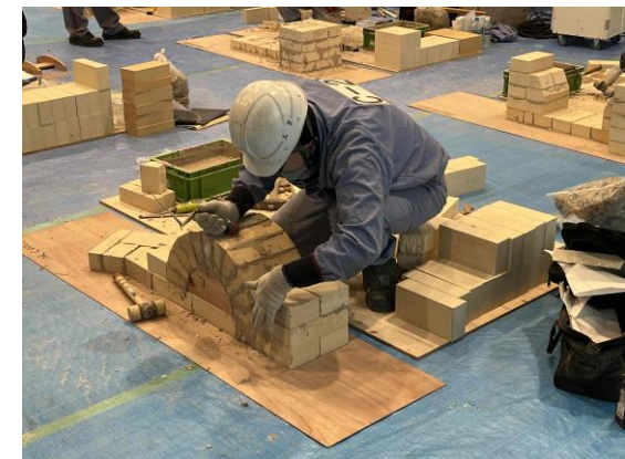
技能検定実技試験（築炉）
