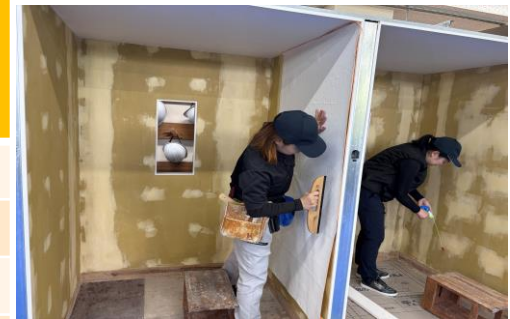
内装施工実習 (インテリアリフォームコース)
