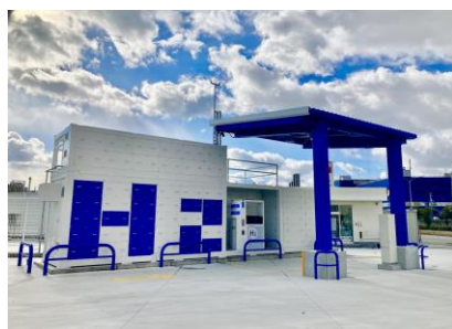
エア・リキードMK神戸空港前 水素ステーション
