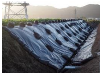
遮光シート設置後
