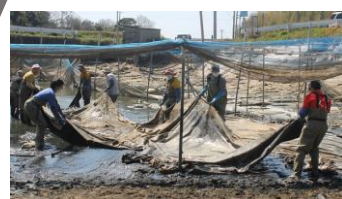
遮光シートの設置
