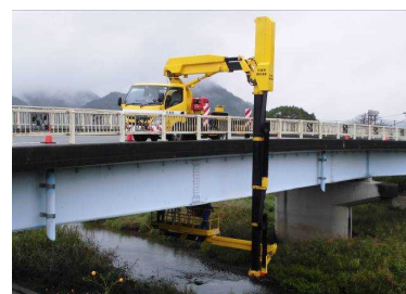
橋梁点検車による点検
