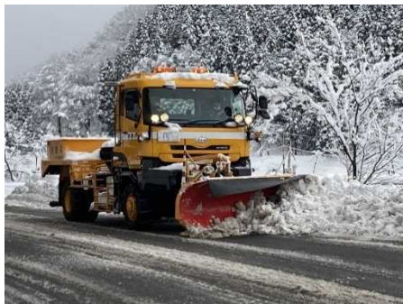
除雪状況 県道香住村岡線（香美町）
