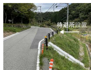
待避所設置 県道島能勢線 (猪名川町)
