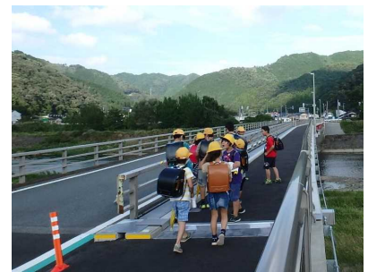
歩道整備 県道上村養父停車場線（養父市）
