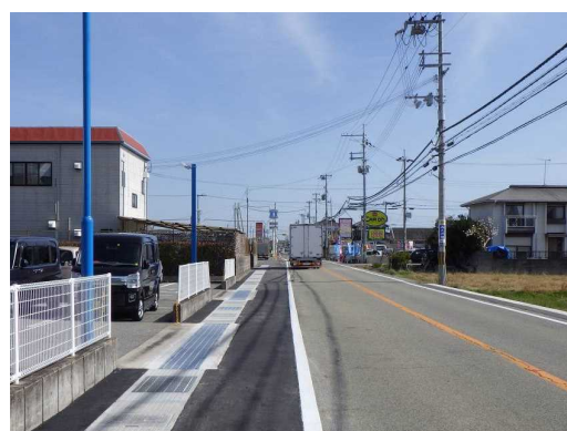
路肩拡幅 県道本荘平岡線 (加古川市)
