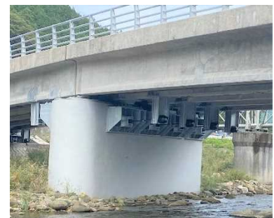
落橋防止装置・橋脚補強 県道加美穴栗線 山田橋（神河町）
