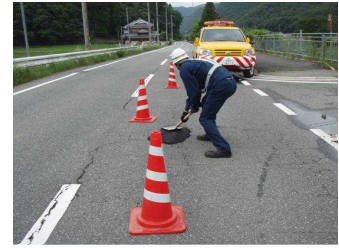
道路パトロールによる路面補修
