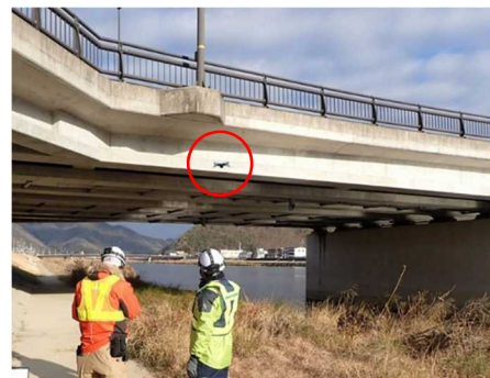
ドローンによる橋梁点検
