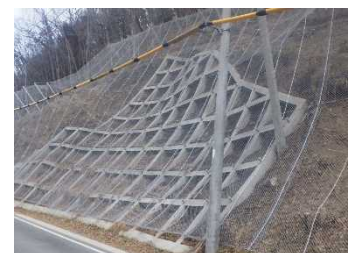
落石防護柵・法柱 国道373号（上郡町）
