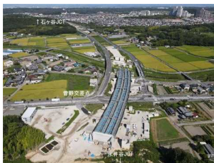
菅野高架橋（神戸市）
