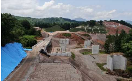
豊岡道路（仮）豊岡 IC 付近（豊岡市）
