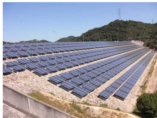
【権現ダム堤体法面】
