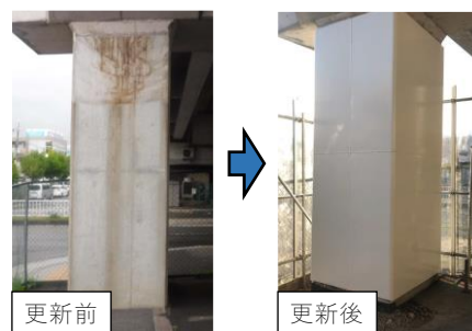
柱の補強(神戸電鉄)
