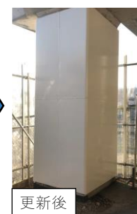
柱の補強(神戸電鉄)
