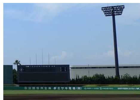
淡路佐野運動公園第1野球場外野フェンス
