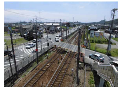
工事前の棚田踏切・棚田交差点
