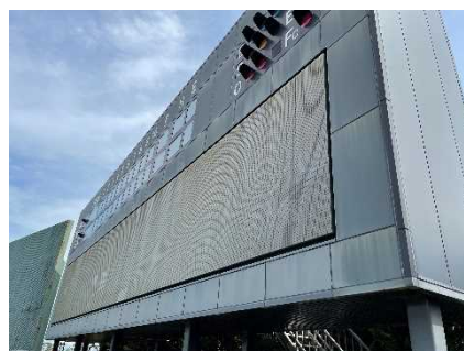
第一野球場スコアボード（現況）
