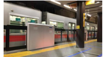
鉄道駅舎ホームドア設置 (阪神神戸三宮駅)
