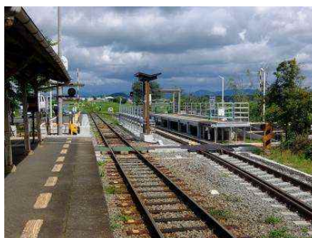
法華口駅 列車行違い設備
