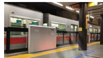
鉄道駅舎ホームドア設置 （阪神神戸三宮駅）
