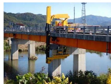
橋梁点検車による点検
