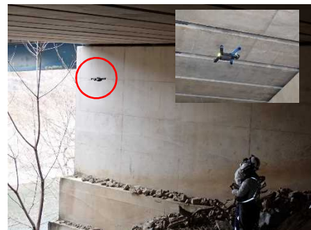
ドローンによる橋梁点検
