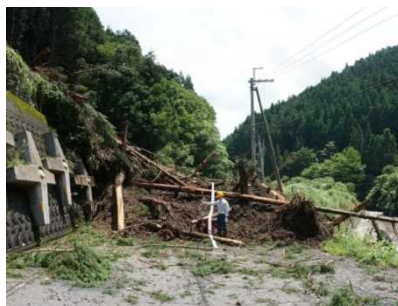
【H30 被災状況】
