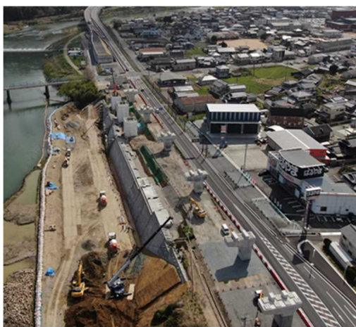
下戸田高架橋 (西脇市)
