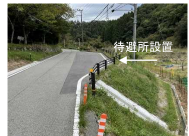
待避所設置 県道島能勢線 (猪名川町)
