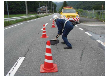
道路パトロールによる路面補修
