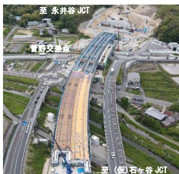
菅野高架橋 (神戸市)
