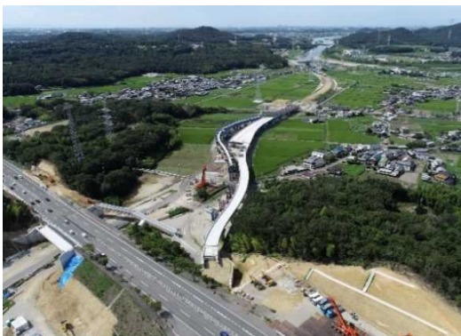
(仮) 国道175号ランプ (小野市)
