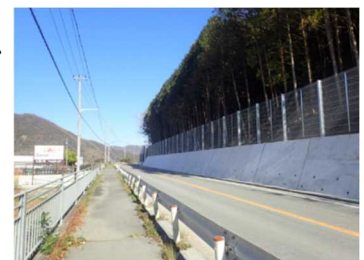
落石防護柵 国道373号 (上郡町)
