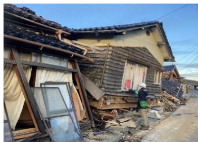
応急危険度判定の様子
