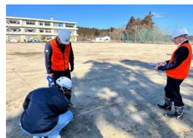
応急仮設住宅建設支援の様子
