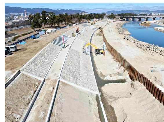
武庫川 (西宮市・尼崎市) [河道拡幅]
