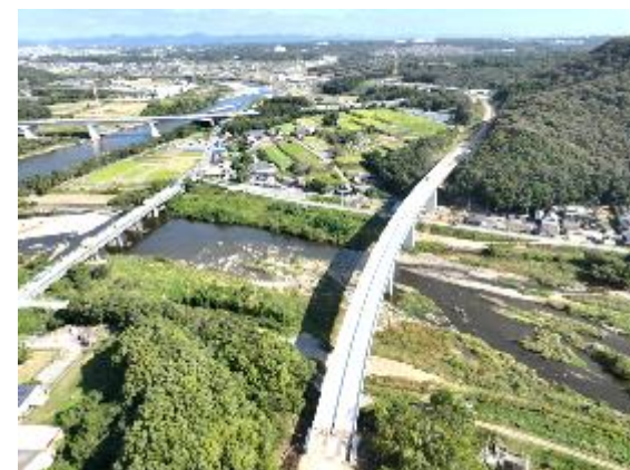
東播磨道(加古川市・三木市・小野市) [舗装工等]
