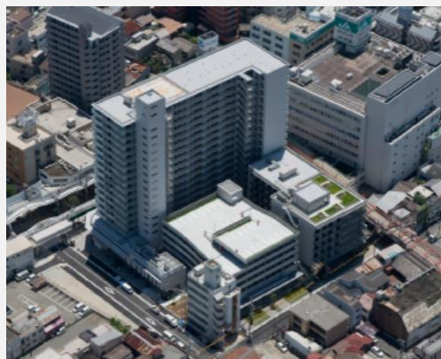
木造建物の共同建替え（加古川市）
